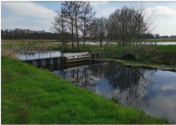
Overlaat Roonboom naar de Marsstroom die in verbinding staat met de Verlengde Hoogeveense Vaart
